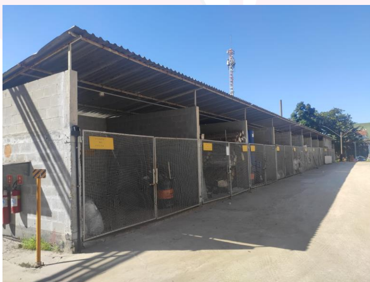
Figura 4 Baias de segregação de resíduos
